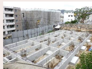
基礎工事写真
