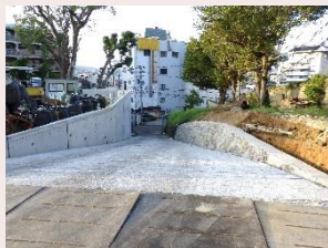
擁壁工事写真
