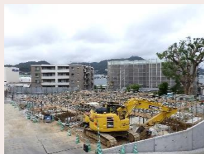
基礎工事写真
